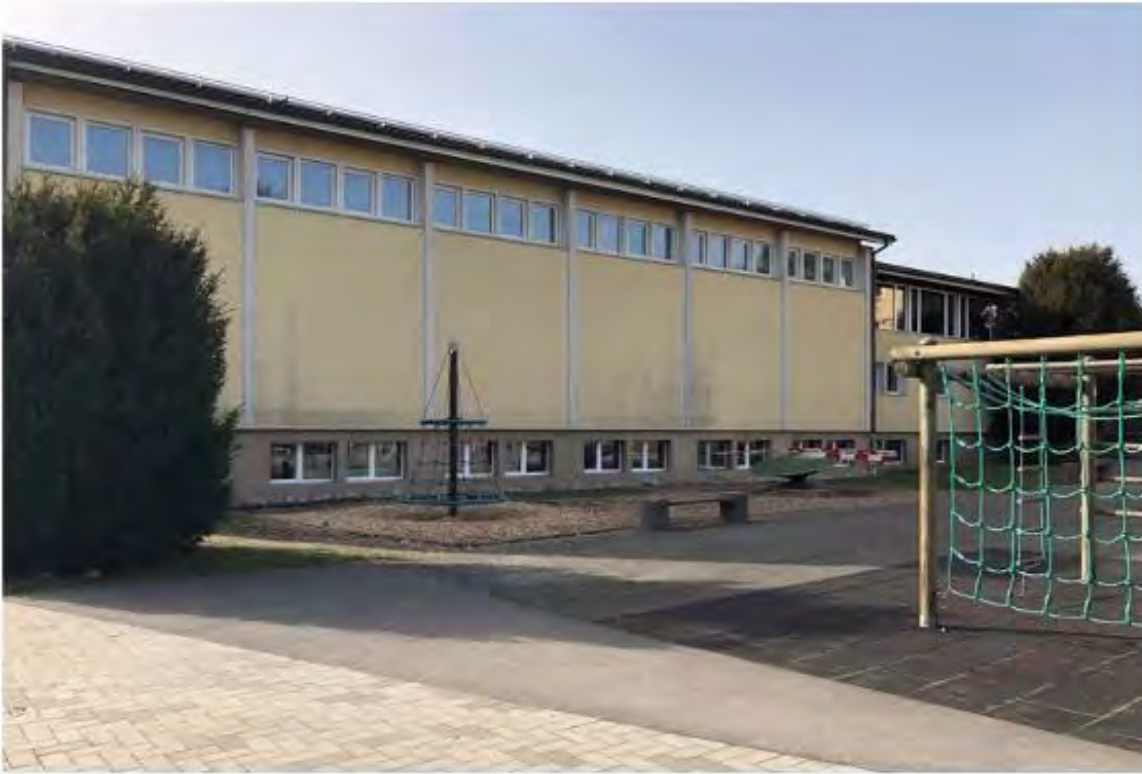
Ostfassade des alten Schulhauses Allmend (LU)
