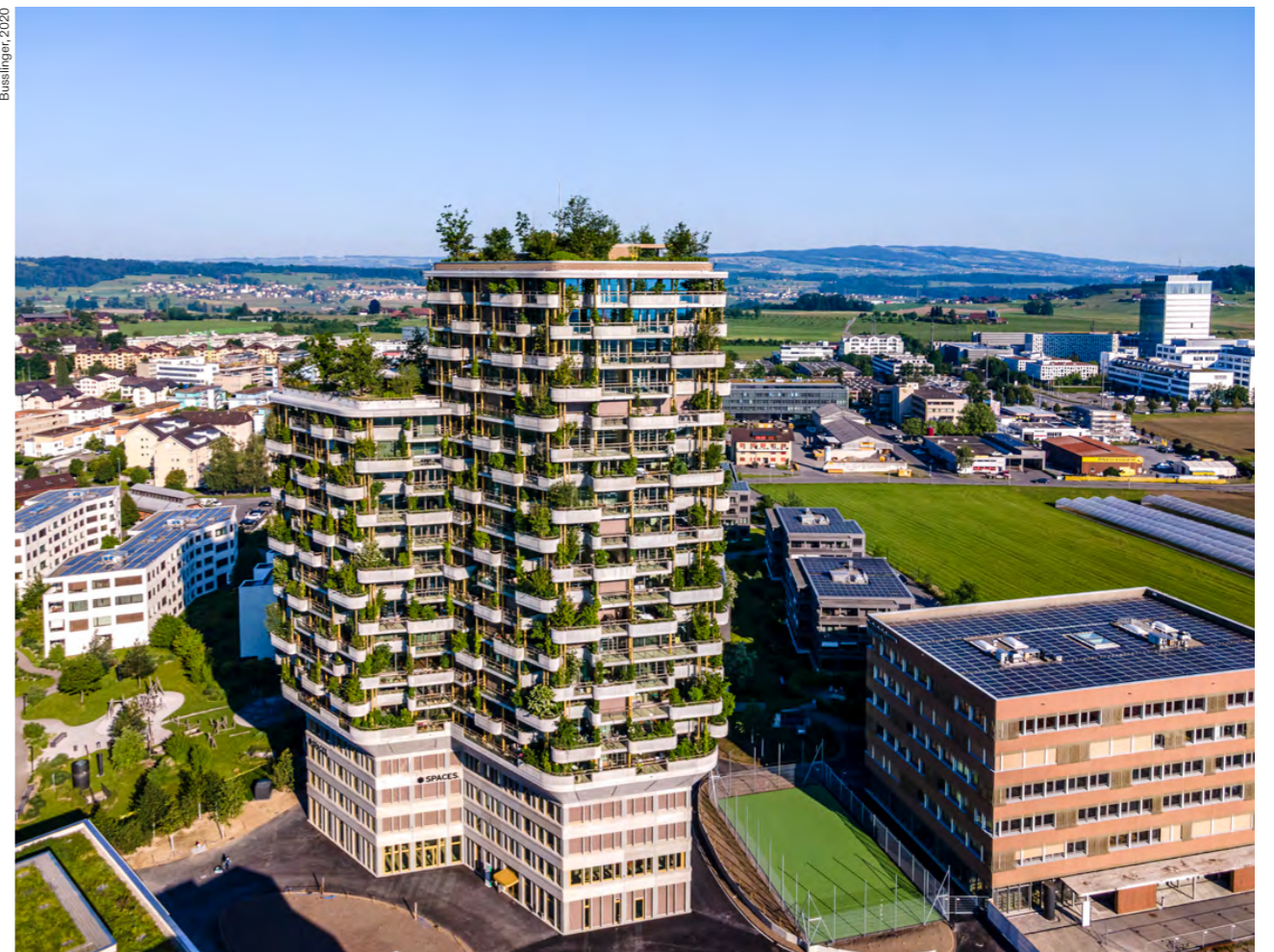
Abb. 4: Vertikale Begrünung beim Gartenhochhaus Aglaya in Rotkreuz
