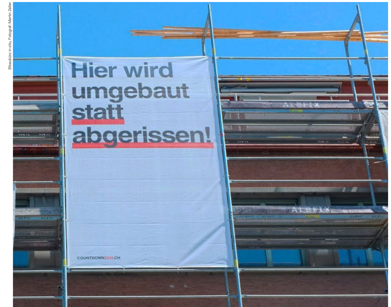
Kopfbau Halle 118, Winterthur CH
